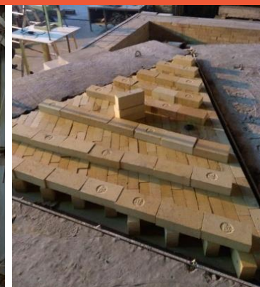
Испытания покрытия RE30 с нагрузкой 230кг/м.кв
