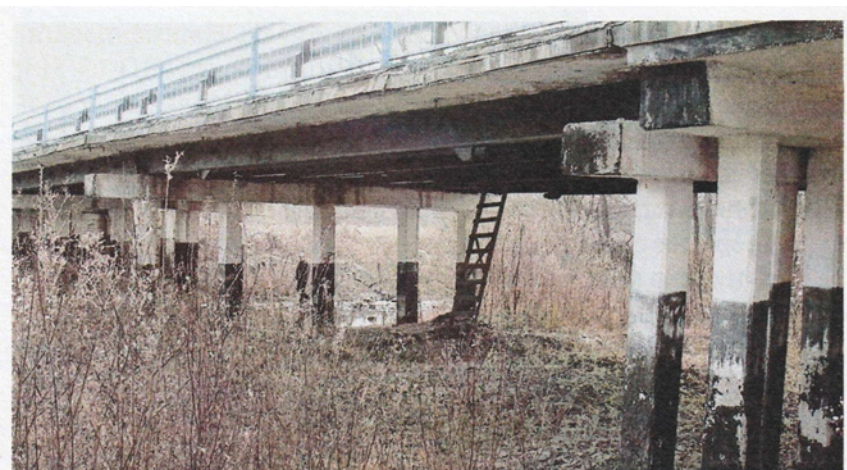
Фото 2. На нижнем поясе крайней балки видны упоры для стеклопластиковой арматуры.
