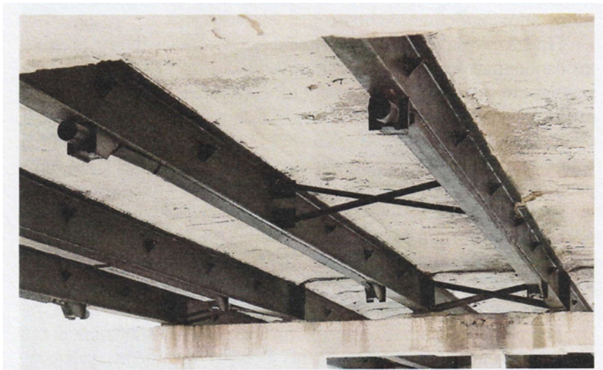
Фото 3. На нижнем поясе балки закреплены пучки преднапряженной стеклопластиковой арматуры.
