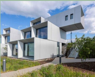
Общежитие Инженерно-технологического института им. Дайсона в Уилтшире, Англия. Компания WilkinsonEyre
