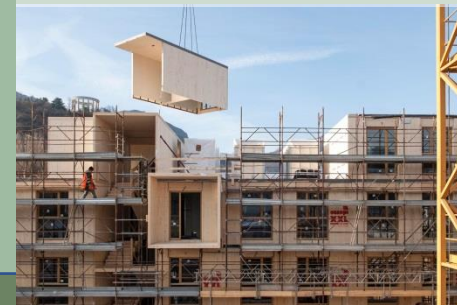
Модульное МКЖЗ, строительство из дерева
