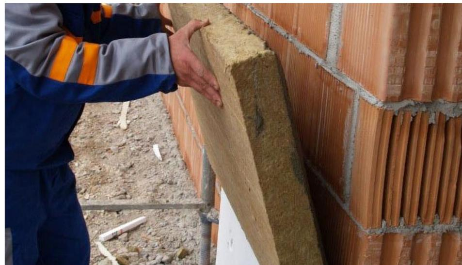
Теплоизоляция зданий и сооружений на основе базальтовой ваты
