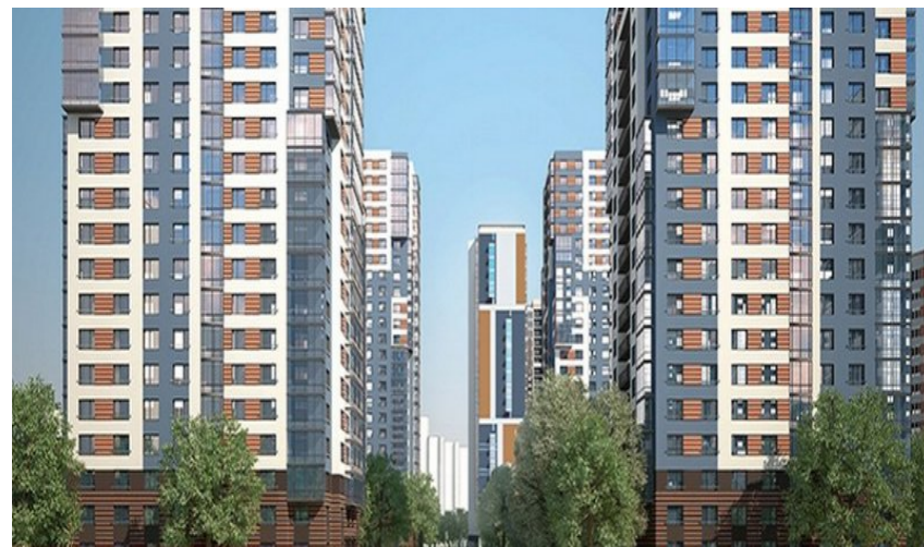
ЖК «Калейдоскоп», г. Санкт-Петербург Низковольтная аппаратура
