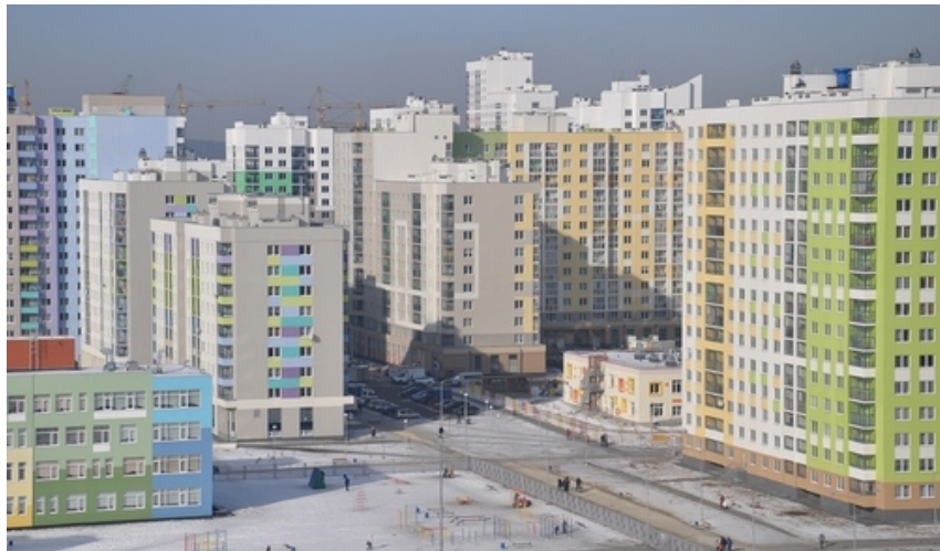
Микрорайон Академический. г. Екатеринбург. Модульное оборудование, LED
