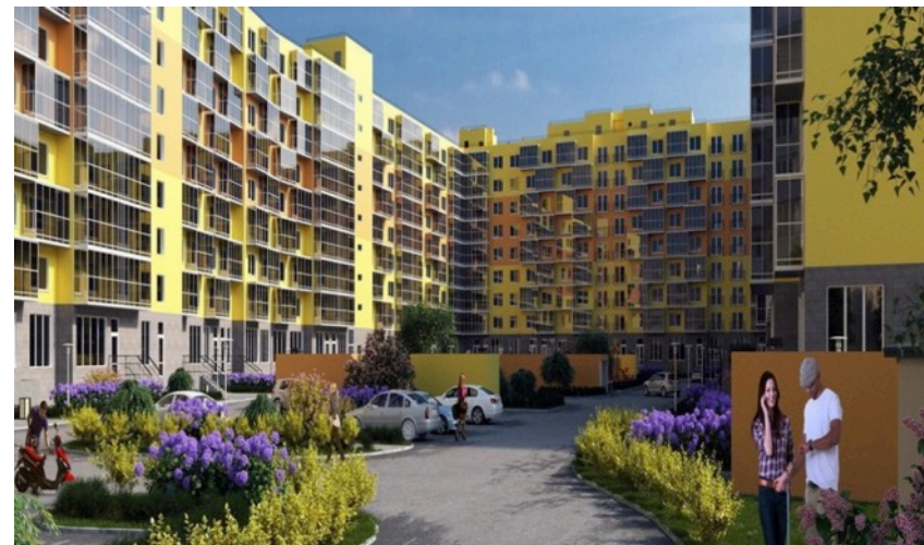
ЖК «Добрыня», г. Санкт-Петербург Низковольтная аппаратура
