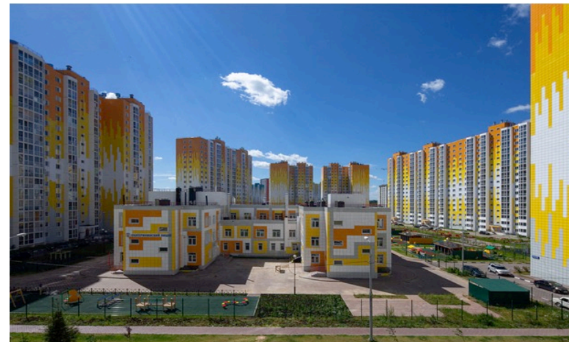
ЖК «Первый Зеленоградский», д. Жилино, Солнечногорский район LED ДПП, АВДТ-63, Монтажные изделия, Трубы ПВХ и ПНД
