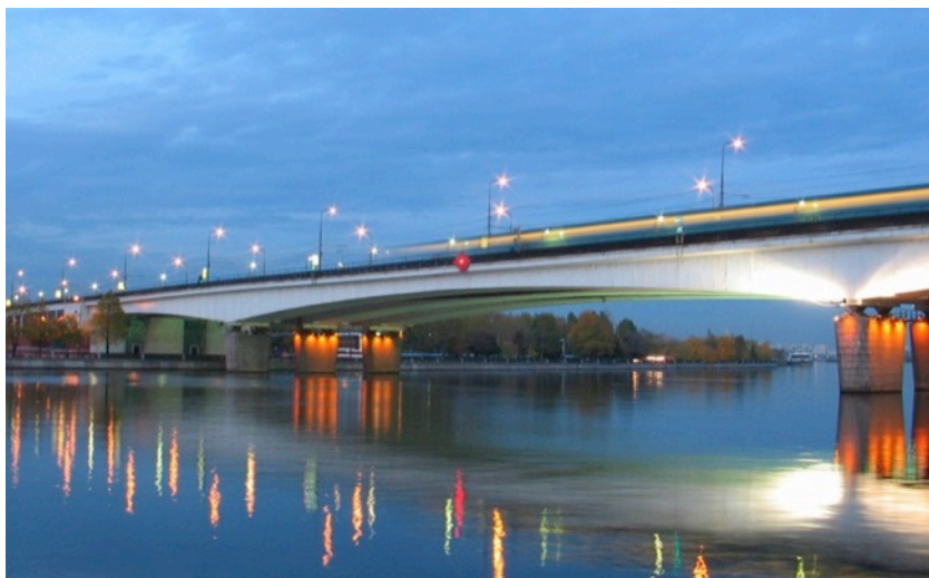
Нагатинский Метромост в Москве. Низковольтное и щитовое оборудование
