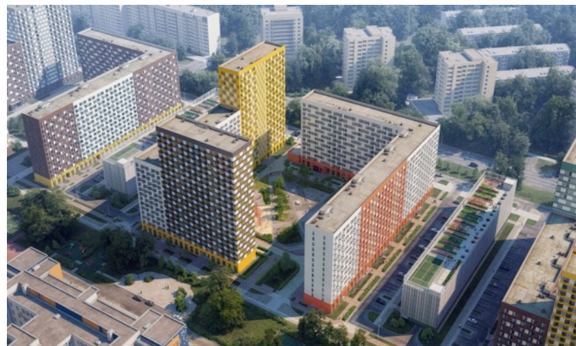
ЖК «Ярославский», г. Ярославль Металлокорпуса, модульное оборудование, электроустановка, освещение
