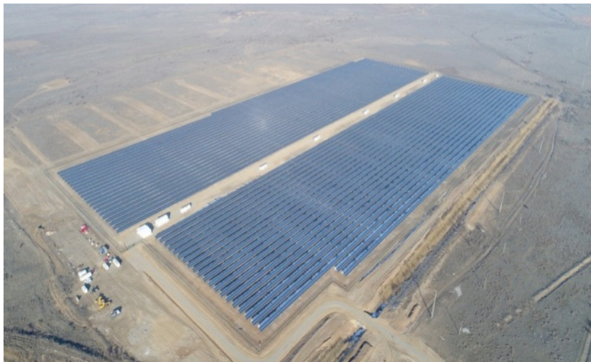
Ахтубинская солнечная станция (Астраханская обл.)
