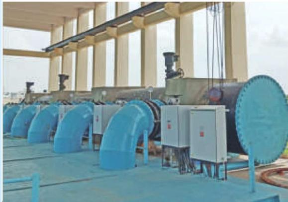
На самой насосной станции водозабора сырой воды (864 млн. л/сут) используются погружные насосные установки компании Aqua (4500 м<sup>3</sup>/час каждая)
