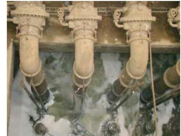
Крупнейший в Индии КОС (172 млн литров в сутки; основан на погружных насосных установках (по 224 кВт каждая) для забора неочищенных сточных вод) работает на насосах Aqua
