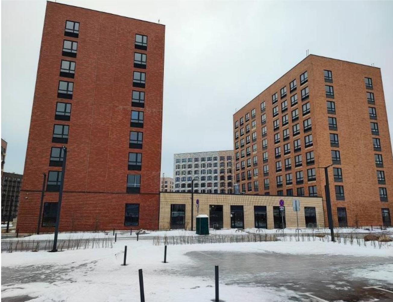
Самый высокий модульный дом в России реализован компанией ПИК на металлическом каркасе и имеет 9 этажей. Жилой дом построен по гибридной технологии и имеет ядро жесткости.
