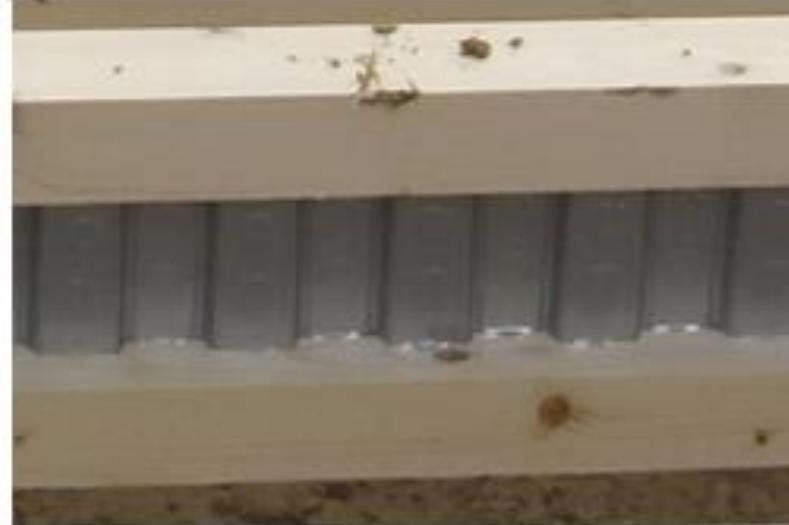
*а* – дерево-металлическая балка перекрытия; *б* – дерево-металлическая балка с гофрированной стенкой
